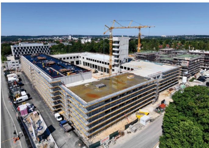
Neubau: Derzeit im Bau befindlich ist die neue Feuer- und Rettungswache 5, die den südlichen Teil Stuttgarts abdeckt.
