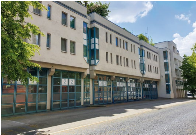
Feuerwache 2: Hier wird gerade eine zusätzliche Logistikhalle gebaut. Für 2025 ist eine Sanierung geplant.
