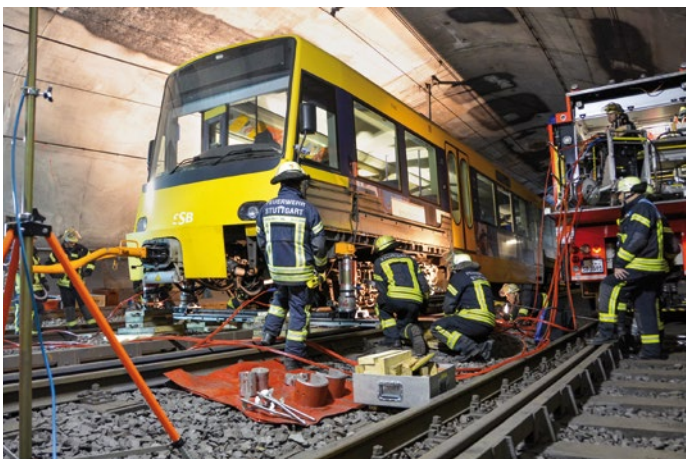
Herausfordernd: Eingleisung einer Stadtbahn auf dem großen Stuttgarter Schienennetz.
